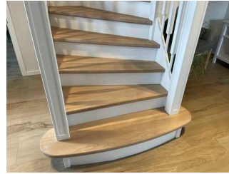
Treppe ins 1. OG
